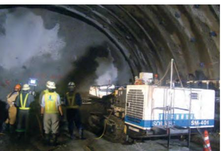
京都府野田川大宮第14トンネル・山陰近畿自動車道：道路トンネルの掘削前の調査において地山の性状を確認するため水圧ハンマーによる高速ボーリングを実施しました。
