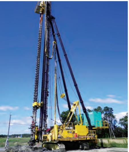
道央圏連絡道路・北海道南幌町：道路新設に際し、盛土部基礎の地盤改良工事を施工しました。
