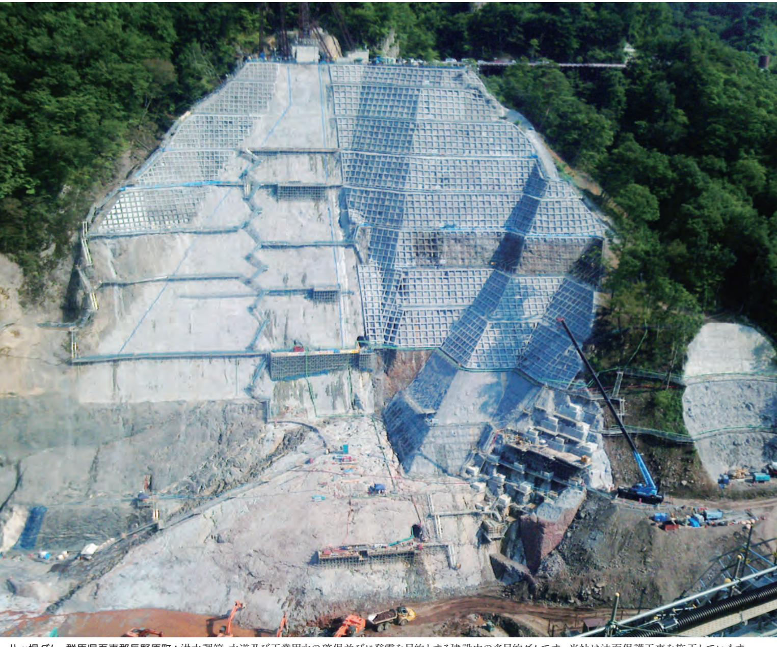
ハッコッドム・群馬県吾妻郡長野原町：洪水調節、水道及び工業用水の確保並びに発電を目的とする建設中の多目的ダムです。当社は法面保護工事を施工しています。
