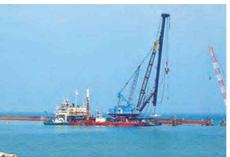
埋立造成地・愛媛県四国中央市：海上を埋立てて造成工事で、遮水鋼矢板を施工しました。
